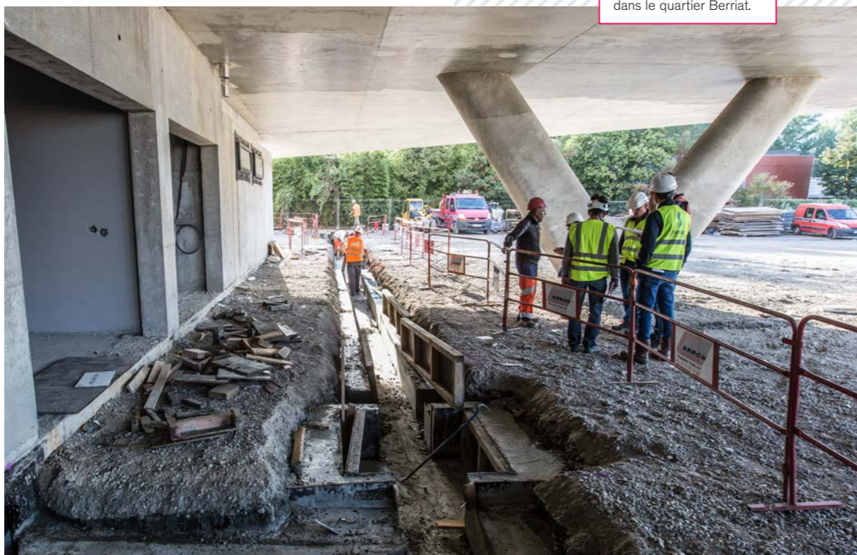
Travaux de raccordement dans le quartier Berriat.
